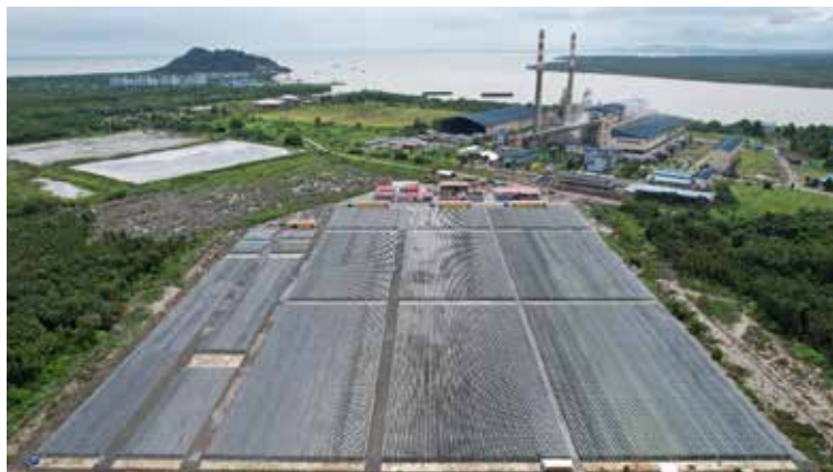
NEDO 事業バイオジェット燃料 生産技術開発事業にて建設された 5ヘクタールの藻類大規模生産設備 （マレーシア サラワク州 クチン市）
